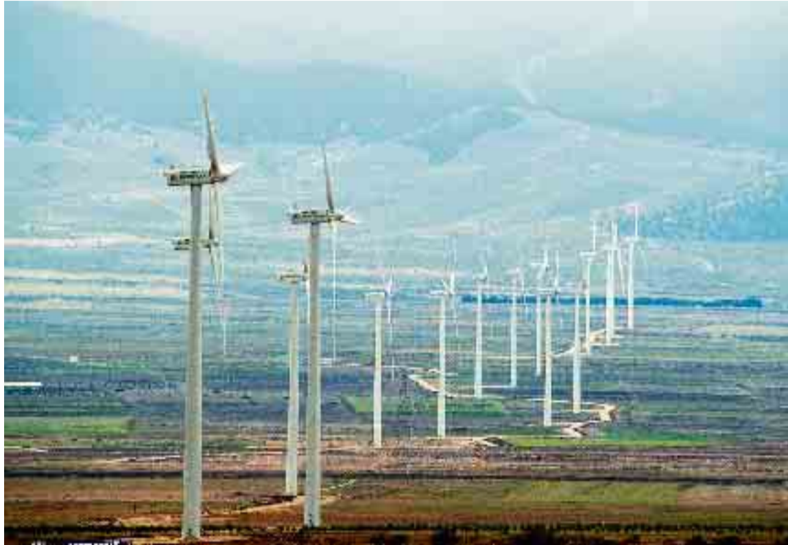
Parque de turbinas de viento en la comarca granadina del Marquesado. / R. C.
