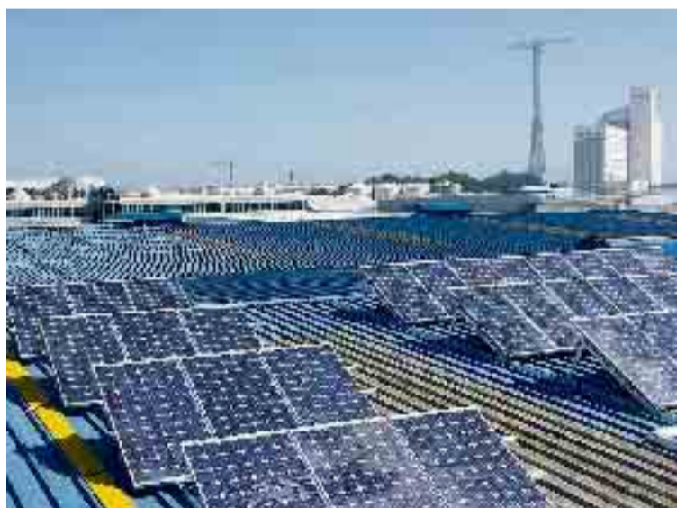
Placas solares en la azotea de un edificio en Cádiz. / R. C.
